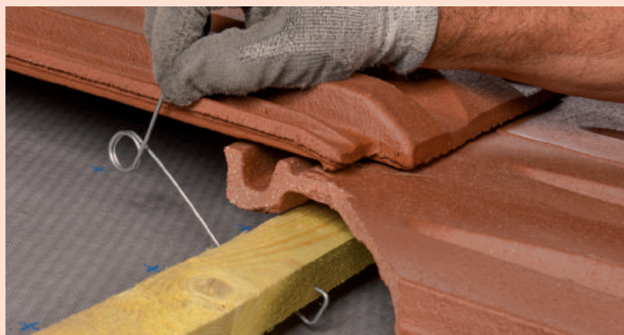
3 - La mise en œuvre peut se faire aussi facilement à la main.
