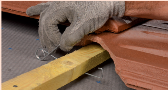
1 - Crochet à harponner en sous face du liteau.
