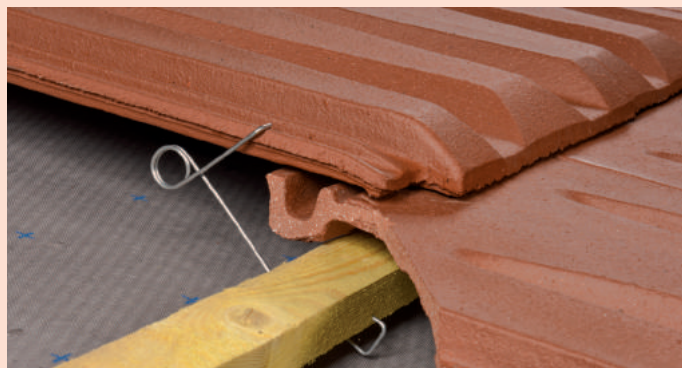
4 - Déposer le crochet dans l'emboîtement de la tuile pour assurer la fixation.
