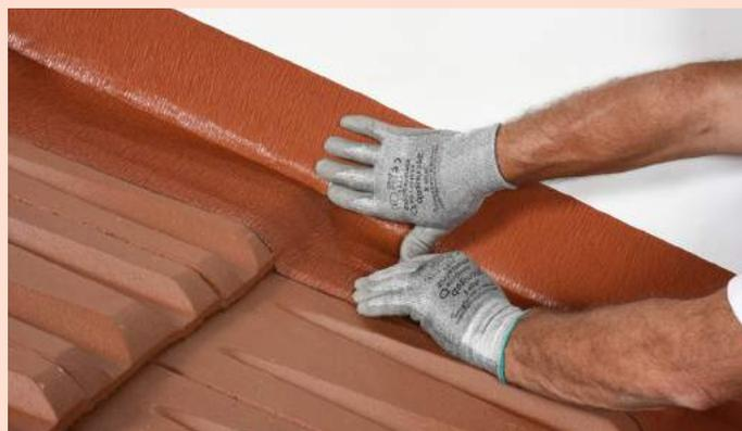
2 - La bande ALTKA® est marouflée sur la tuile de manière à avoir une étanchéité optimale. La pose entre deux bandes s'effectue dans le sens de l'écoulement des eaux pluviales et avec un recouvrement d'au minima 5 cm.
