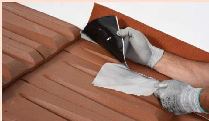
1 - Après avoir positionné la tuile au plus près du mur, placer la bande ALTKA® de manière à conserver 9 cm par rapport au point le plus haut de la tuile tout en assurant un recouvrement de la garniture jusqu'au-delà du relief \* de la tuile entière.
