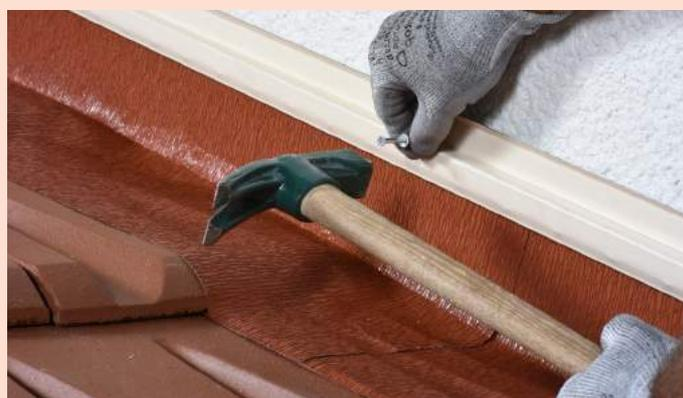
4 - Utiliser des chevilles à frapper, adaptées au support et assurant une fixation étanche. Mettre en place un joint mastic dans le pli résistant aux UV.
