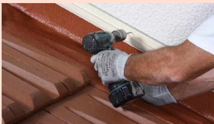
3 - Afin d'assurer une finition et une étanchéité parfaite, une bande de solin joint mastic est positionnée sur l'ALTKA® de manière à la recouvrir de 3 cm. Percer la bande aux endroits souhaités pour la fixation.
